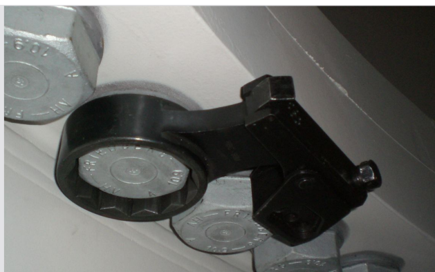
alkitronic® Konterschlüssel eingesetzt am Schraubenkranz in einer Windkraftanlage.
