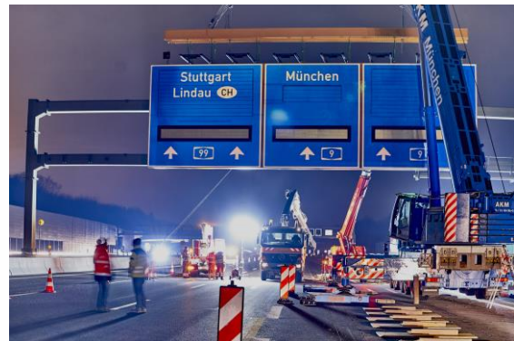
Abbildung 1: Verkehrsschilderbrücke, Foto: Firmengruppe Max Bögl / Reinhard Mederer
