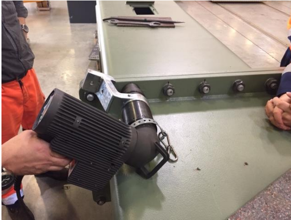
Abbildung 2: Die abgewinkelte Form des alkitronic® ECWip erleichtert das Verschrauben an Schilderbrücken.
