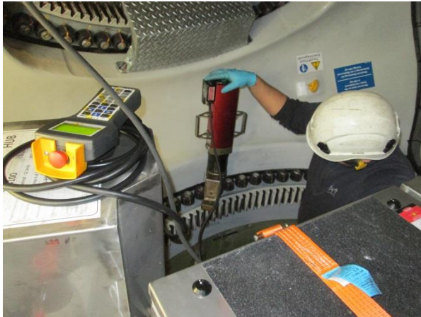
Abbildung 9: alkitronic® EF 300plus am Rotorblatt
