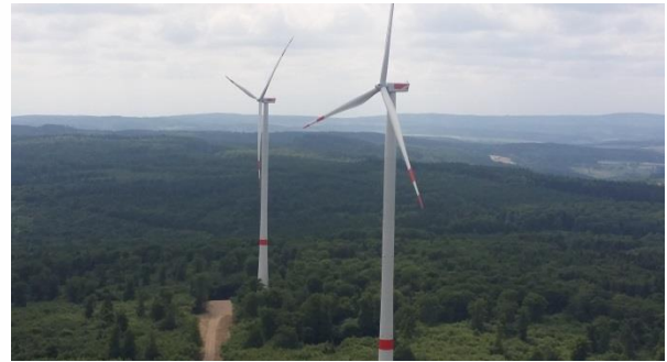
Abbildung 10: GE 2.8 auf 140m-Hybridturm
