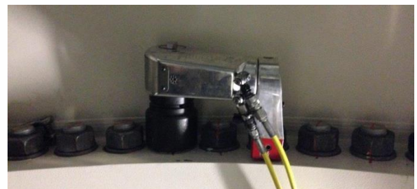
Abbildung 5: alkitronic® Hydraulik-Drehmomentschrauber AS-15 an Turmflanschschauben M64-HV
