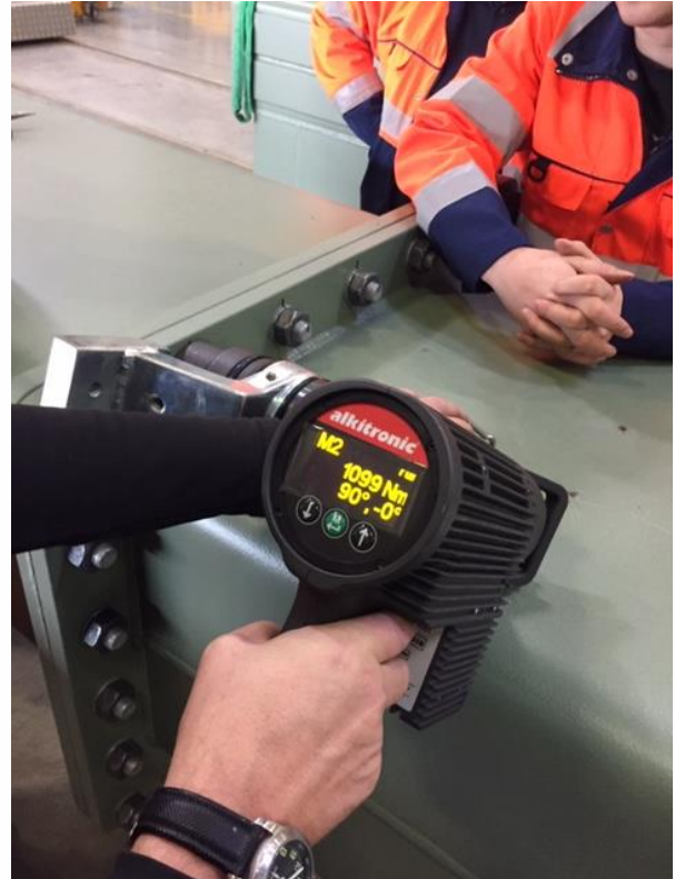
Illustration 1: Vissage selon la procédure couple/angle
