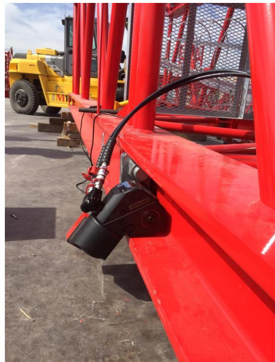
Figure 3 : Essai avec la clé hydraulique AT d'alkitronic
