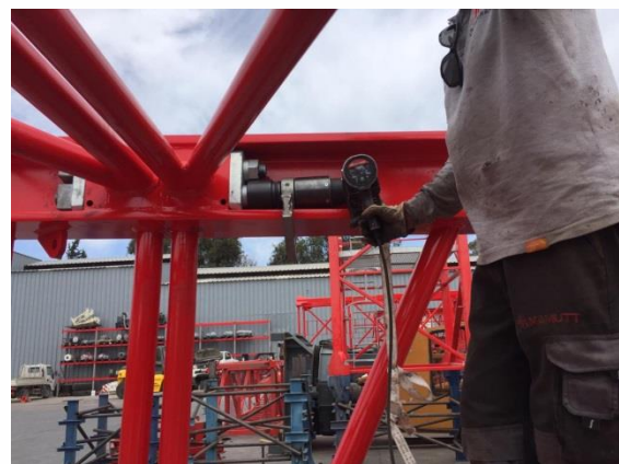
Figure 1 : La visseuse électrique à angle ECWip100 d'alkitronic au niveau de la boulonnerie de la grue.
